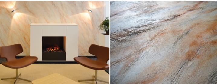
Gebrochener Stein „pietra spaccata“: Bei dieser Technik wurde ein Kalkputz aufgetragen, strukturiert und in mehreren Arbeitsschritten mit Lasuren veredelt.
