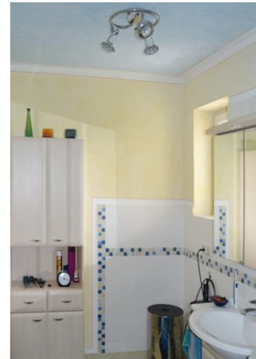
**Wischtechnik:** Hier wurde ein Bad mit 2 verschiedenen Farben passend zur Einrichtung und den vorhandenen Fliesen gestaltet. (Dabei werden eingefärbte Lasuren mit einer Bürste in mehreren Arbeitsgängen aufgetragen und anschließend wird der Übergang mit einem dünnen Strich als Abschluss versehen.)
